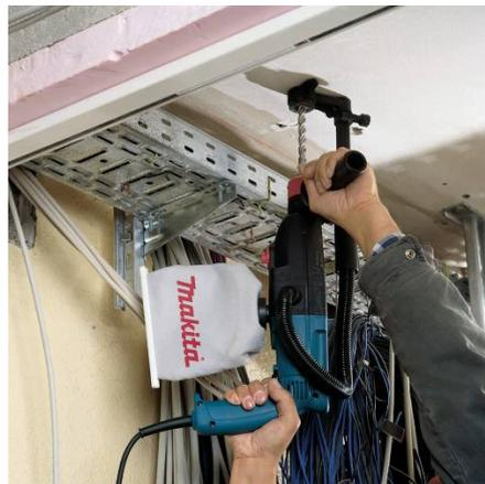
**Bild 3:** Bohrhammer
