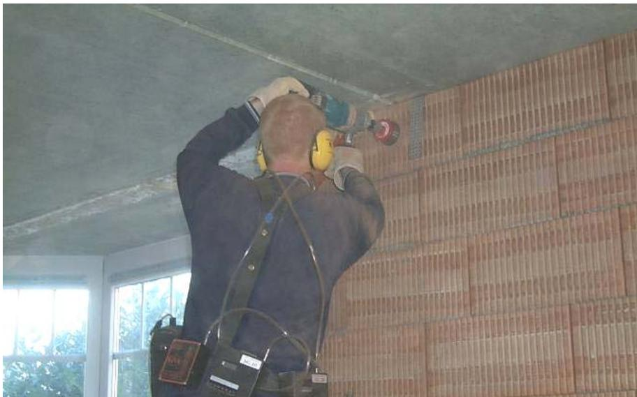
**Bild 10:** Dosensenken ohne Absaugung in einem Rohbau
