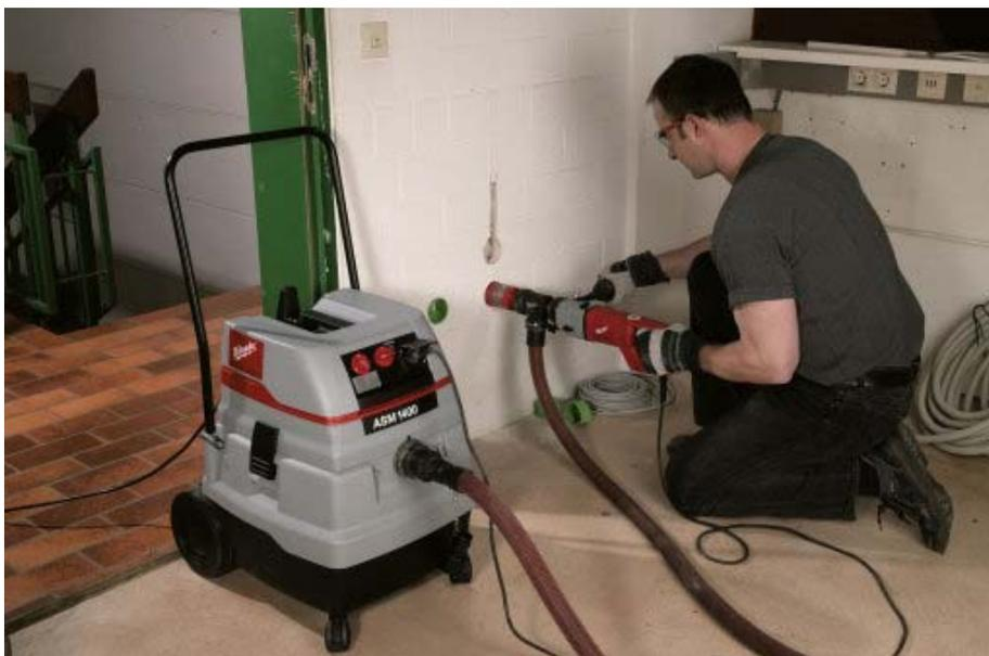
**Bild 11:** Dosensenken mit Absaugung
