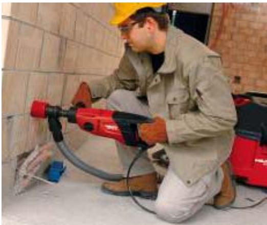
**Bild 2:** Diamantbohren, Dosen senken
