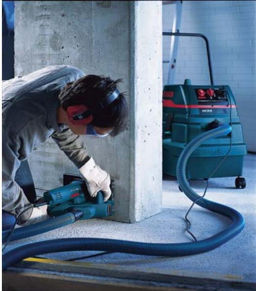
**Bild 4:** Mauernutfräse und Entstauber
