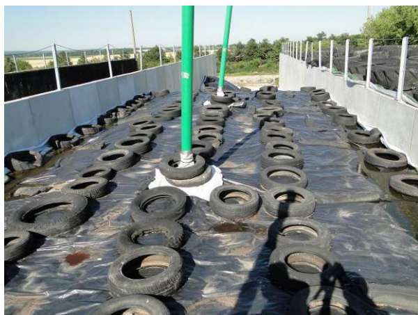
Abbildung 67: Gesamtansicht Trockenmiete am 28.06.2011
