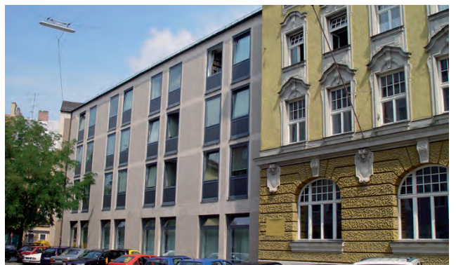
Abbildung 4: Das Dienstgebäude Pfarrstraße München
