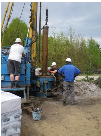
Abbildung 32: Ausbau der zur Stabilisierung des Bohrloches eingebauten Verrohrung, Mai 2013 (Foto: Lindig; IWB 2013)
