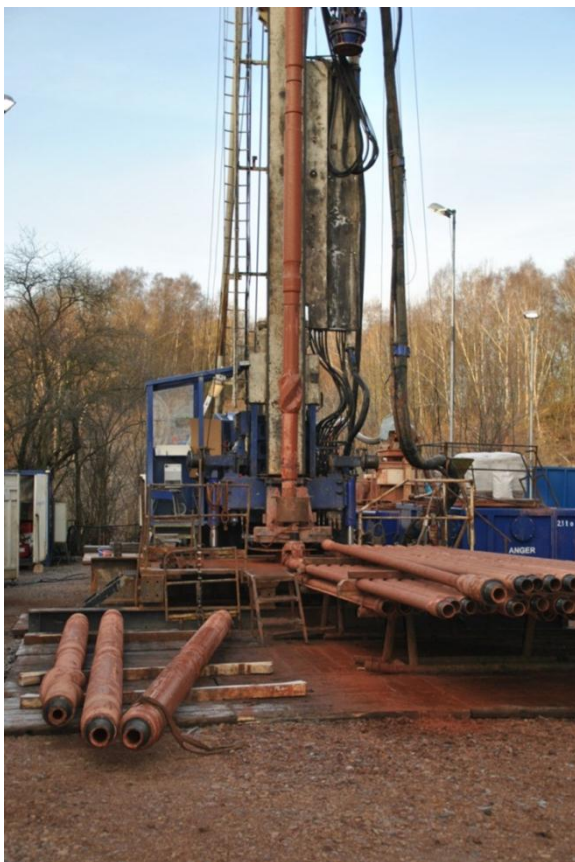
Abbildung 16: Tiefbohrgerät der Firma Anger's Bohr- und Brunnenbaugesellschaft mbH (Foto: Anger's Bohr- und Brunnenbaugesellschaft mbH 2013)
