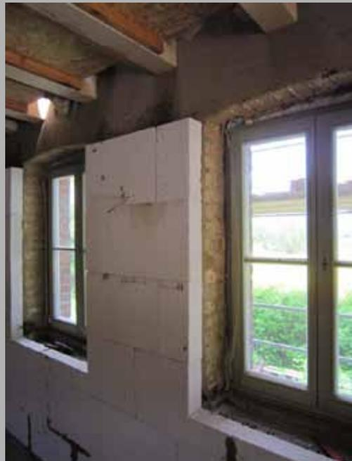
Innendämmung mit Kalzium-Silikat-Platten und Wandheizflächen mit Kapillarrohrmatten
