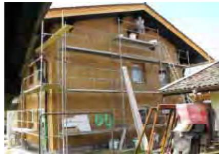
Ostfassade fast fertiggestellt mit 14 cm Dämmplatten
