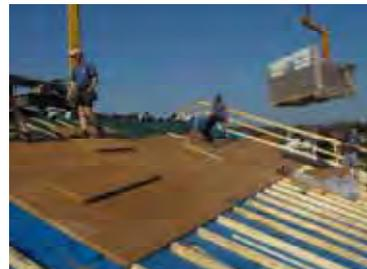
Verlegen der Aufdachdämmung aus Holzfaser
