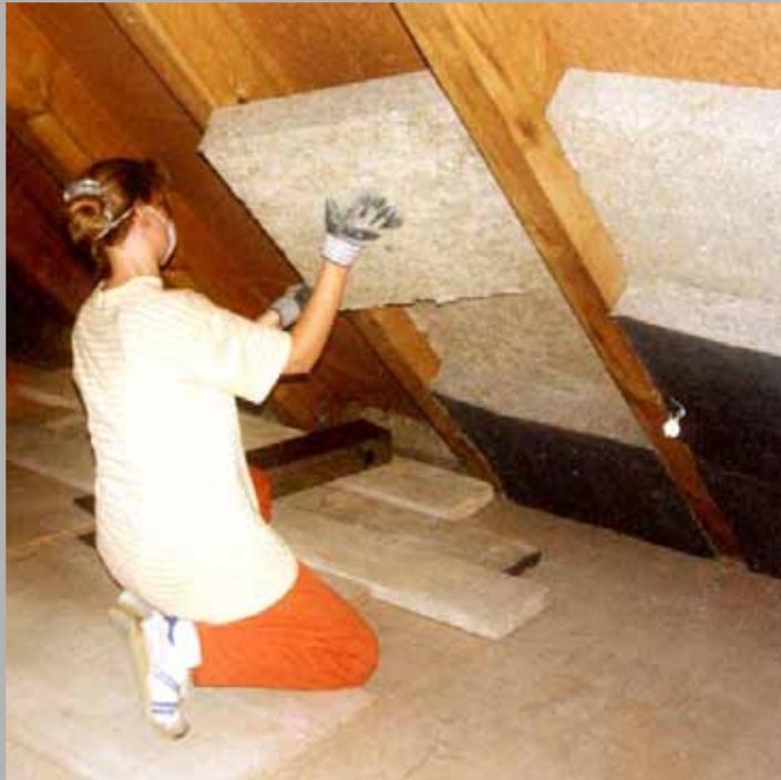
Einbau Zellulosedämmplatten von Bauherrin
