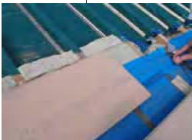
Anschlussdetail Folien und Hanf-Dämmung
