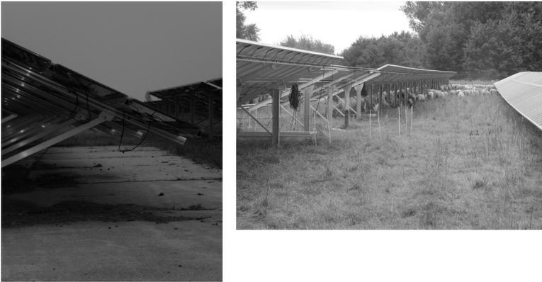
Abb. 7: An frei hängenden Kabeln können die Schafe hängen bleiben, Bereiche mit technisch bedingt frei hängenden Kabeln (z. B. Bereiche um die Gleichrichter) müssen ausgekoppelt werden
