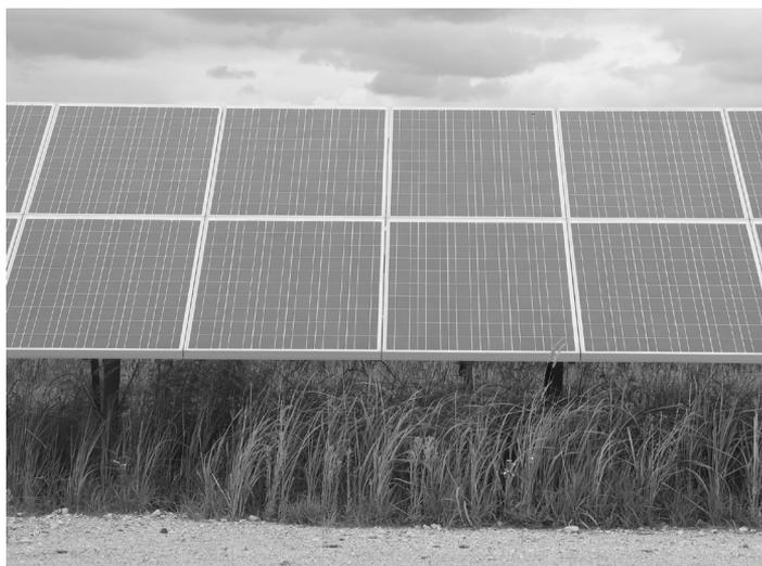
Abb. 1: Die Pflegemaßnahmen müssen dafür sorgen, dass die Unterkante der Solarpaneele nicht überwachsen wird
