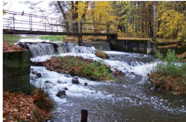
Abb. 99: Ehemaliges Gabelwehr Lindenau (Pulsnitz, 2008)
