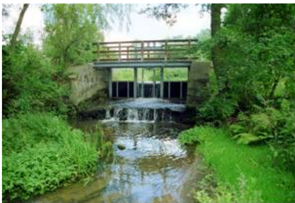
Abb. 115: Wehr Gramzow (Schlatbach; vorher)
