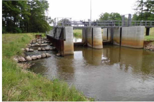
Abb. 119: Wehr Kotschka (Pulsnitz)
