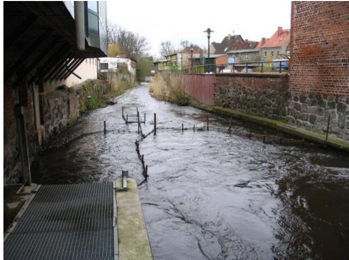
Abb. 51: Smolt-Falle in Perleberg (Betriebszustand)
