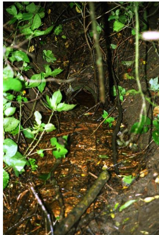
Abb. 27: Alte Dränage in der Kümmernitz
