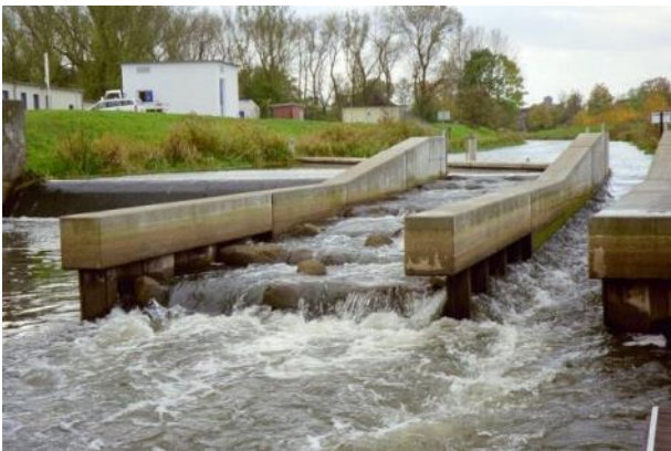
Abb. 125: Messwehr Pasewalk
