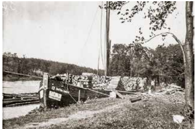
Abb. 9: Ablage am Finowkanal für Brennholz und Flösse.
