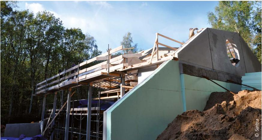
Bild 6.15: Partikelschaum-Dämmstoff
