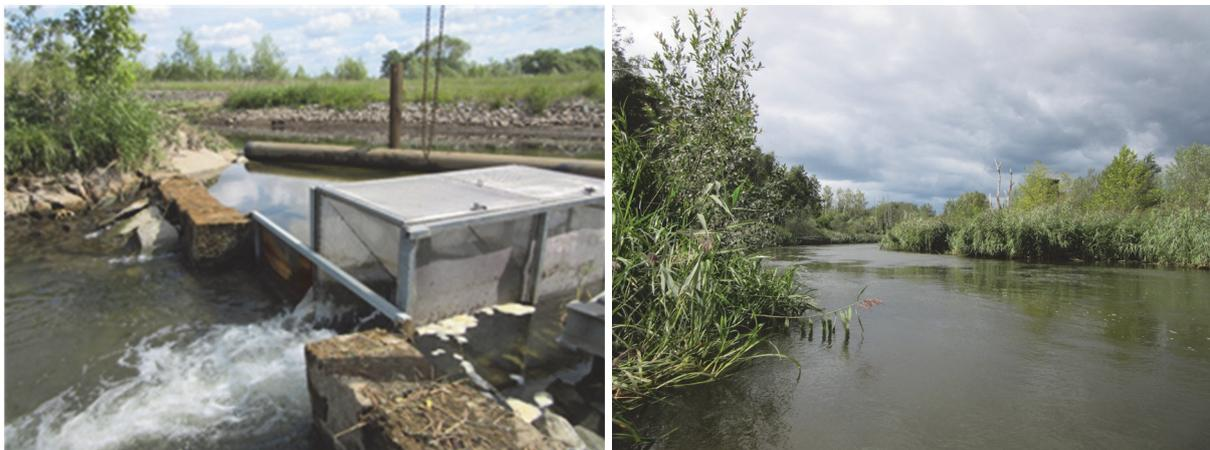
Abb. 1: links - Kontrollreuse oberhalb der Fischwanderhilfe, rechts - renaturierter Bereich im Oberlauf
