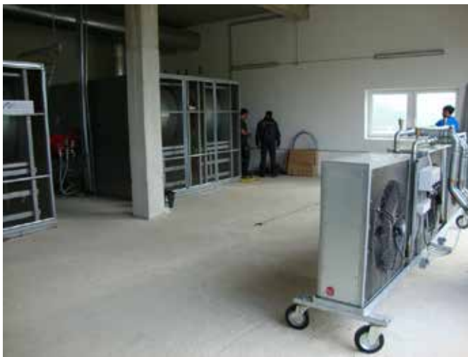
Abb. 73: Positionierung eines Warmwasser-Heizregisters mit Gebläse im Ansaugluftstrom zweier Warmlufterzeuger
