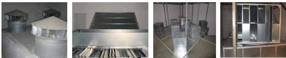
Abb. 7: Beispiele unterschiedlicher Luftverteilsysteme: Verteilhauben, Lamellen, Diffusoren und Drehverteiler (von links nach rechts)
