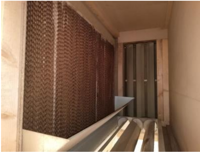
Abb. 82: Kühl- bzw. Feuchte-Pad zum Einstellen der richtigen Belüftungsluft
