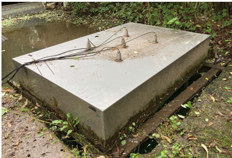
Abb.11: Die UV-Einheit im Zulauf der Forellenzucht.
