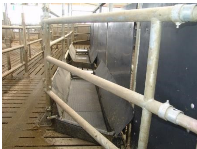
Abbildung 27: Neu installiertes Klauenbad des Betriebes 6_7 bei der zweiten Systemanalyse
