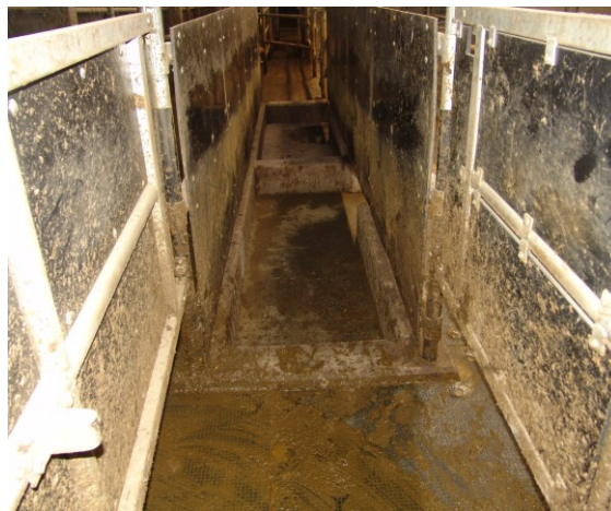
Abbildung 26: Zwei fest installierte Durchlaufbecken mit seitlich geschlossenen Wänden und separaten Abflüssen
