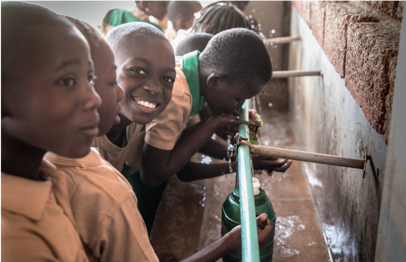
Trinkwasserspender für die Kinder einer Grundschule in Dano, Burkina Faso
