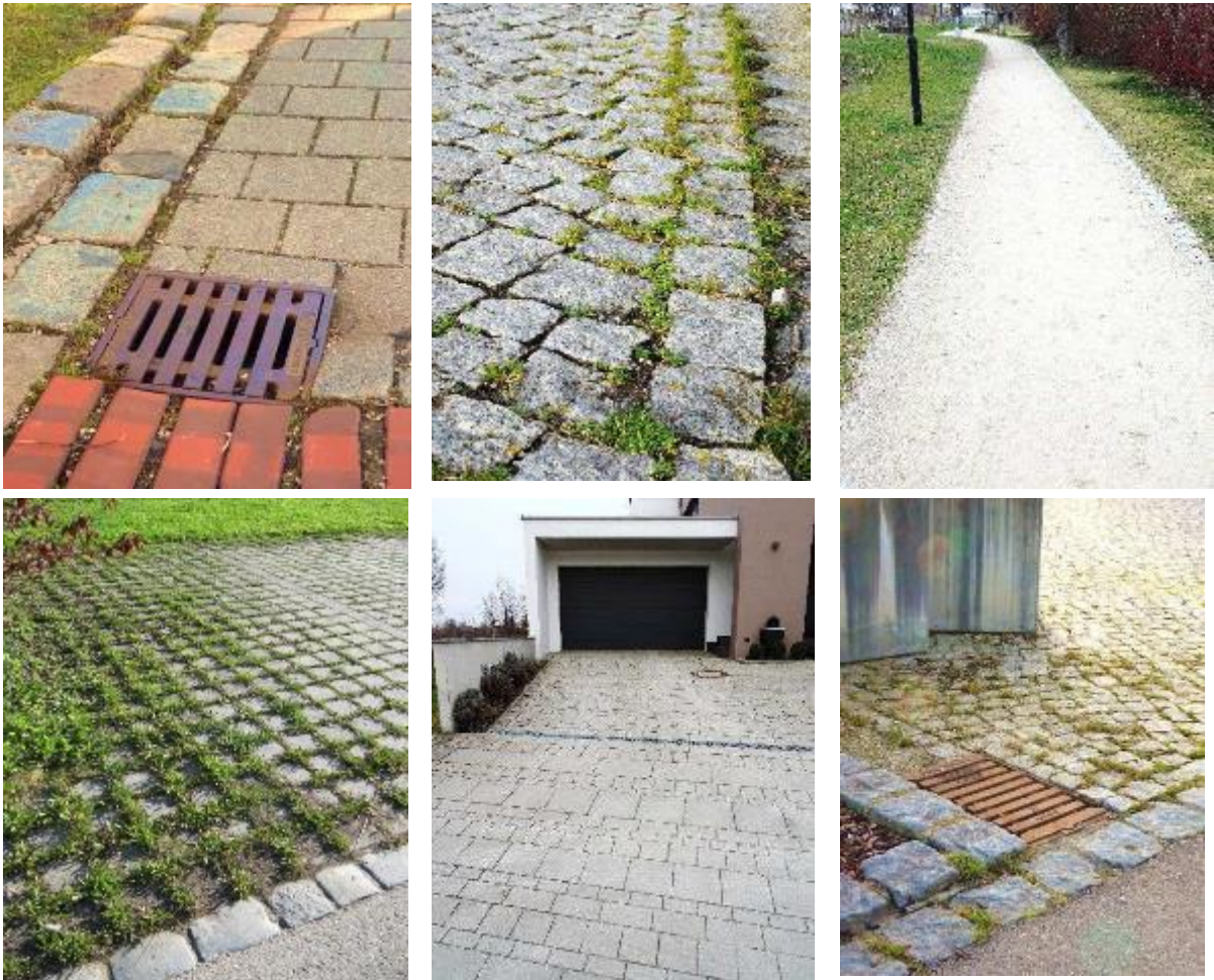
Abb. 13 – 18: Auf gepflasterten und anderweitig befestigten Flächen ist die Anwendung von Pflanzenschutzmitteln grundsätzlich verboten!
