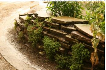
Abb. 44: Wiederverwendung von Baustoffen zum wegbegleitenden Mauerbau in der Kleingartenanlage „Bebericher Grund“, Viersen (eigene Aufnahme, 08.07.2014)
