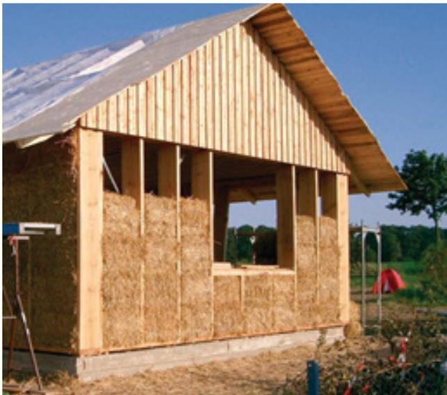
Abb. 23: „Typische Strohhallenhäuser sind in der Regel nur im Bau als solche ersichtlich, später schützt eine Putzschicht vor eindringender Feuchtigkeit“
