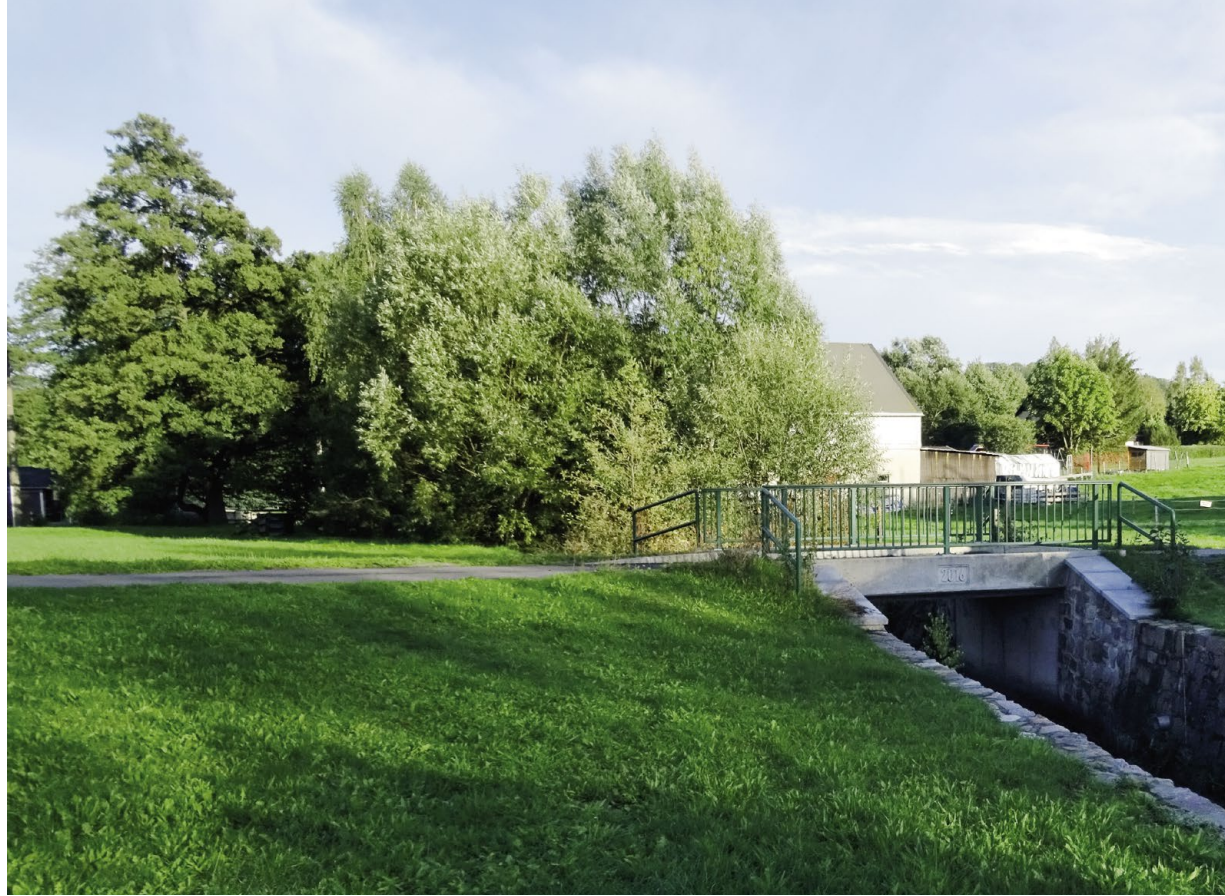
Brücke über den Großhartmannsdorfer Bach in Weigmannsdorf
