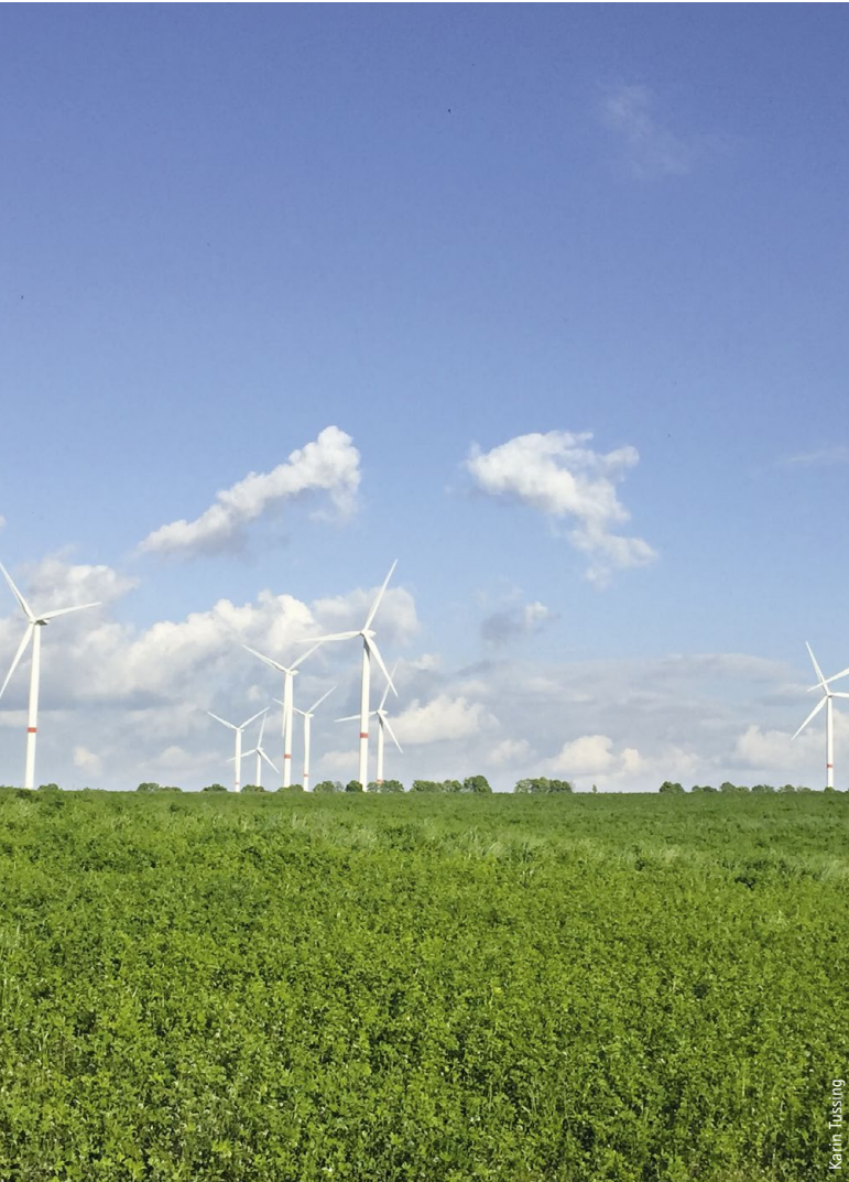
Windenergieanlagen in der Nähe der Stadt Meißen
